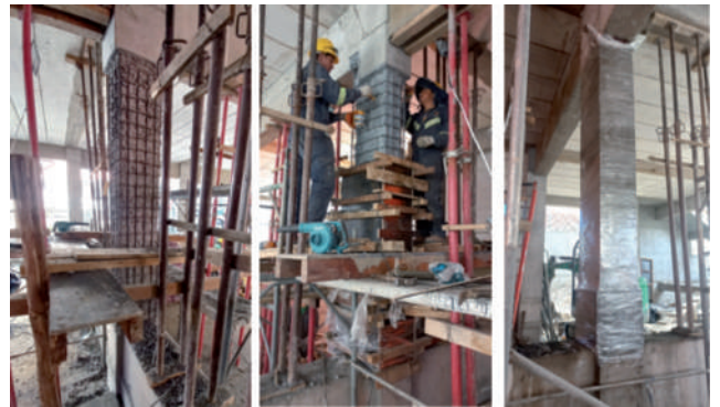
Figura 7. Proceso de rehabilitación estructural.
