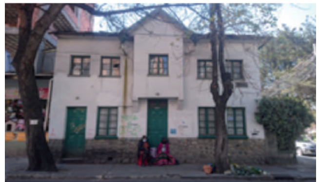
Figura 4. Fachada principal del inmueble
