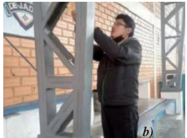
Figura 3. Toma de datos de las a) geometría y b) lesiones de los perfiles conformados en frío Fuente: Elaboración propia.
