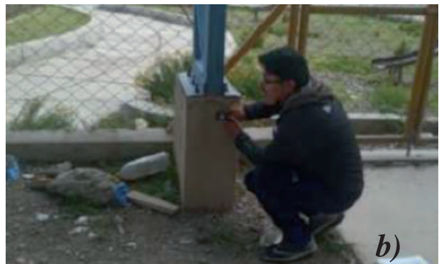
Figura 2. Toma de datos de las a) geometría y b) lesiones en los pedestales de hormigón armado Fuente: Elaboración propia.
