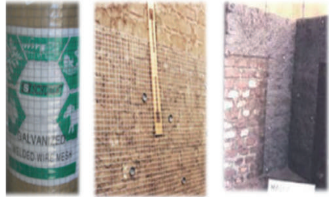
Figura 21. Malla electrosoldada, instalación y recubrimiento
